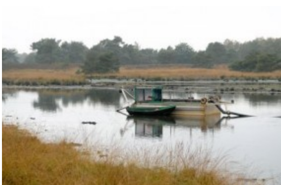
Figuur 11.121 Voor het verwijderen van de sliblaag uit het Groot Huisven werd gebruik gemaakt van een speciale baggerboot. Met een pijpleiding werd het slib naar een depot buiten het gebied vervoerd. Hier werden volgens een speciale zeefmethode zand, humus en water gescheiden. Waarna het geschoonde water weer terug werd gevoerd naar de vennen (Foto: Natuurmonumenten).
