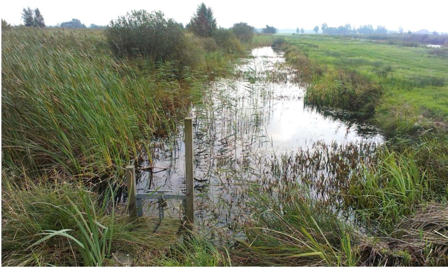
Afbeelding 3.7 Aanvoerwatergang door cluster 2 naar cluster 6. Op de voorgrond de schuif voor doorlaat van water naar cluster 6
