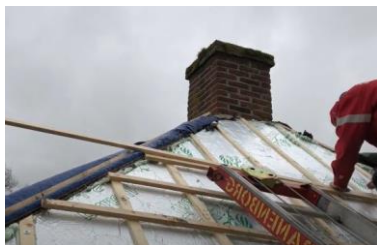
Figuur 5: Het plaatsen van isolatiemateriaal op het dak waarbij de dakconstructie niet wordt aangepast.
