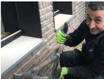
Figuur 9: De spouwmuur opvullen met vloeibaar isolatiemateriaal (pur, eps, parels, etc)
