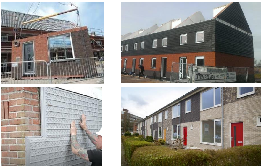
Figuur 12: Twee voorbeelden van isolatie van buitenaf. (Boven) het plaatsen van een kant en klare langgevel. (Onder) het plaatsen van isolatie materiaal op een bestaande gevel. Hierbij worden eventuele openingen (zoals een lintvoeg/ stootvoeg) afgedekt.
