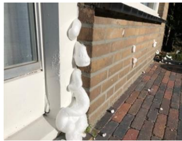
Figuur 8: Voorbeeld van een boorschema. Alle mogelijke randen waar materiaal uit zou kunnen komen worden meestal van te voren gedicht.
