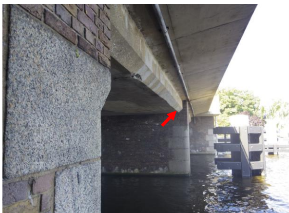
Figuur 36: Op de overgang tussen metselwerk en beton zitten dilatatievoegen. Hier is ruimte voor overwinterende vleermuizen.
