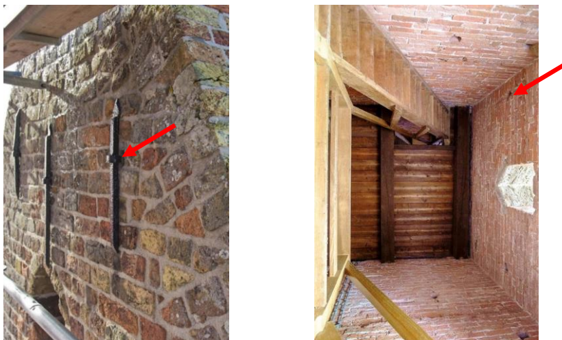
Figuur 35: Links een muuranker met een gat voor vleermuizen (rode pijl). Rechts de binnenzijde van een toren met de ladder tussen twee verdiepingen. Bij de overgang van de balk in de muur zit een ruimte voor vleermuizen (rode pijl). Ook zijn hier de balkgaten nodig tijdens de constructie nog goed te zien (zwarte pijl).
