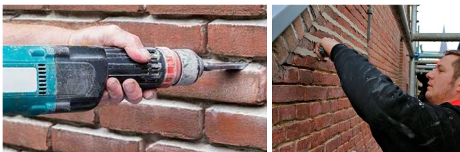
Figuur 13: het uithakken van voegen gebeurt o.a. met een hakhamer, luchthamer of met een slijptol met een speciaal voeg snijblad.
