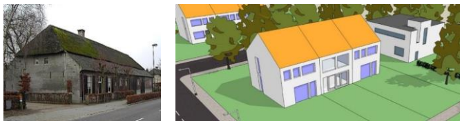
Figuur 70: (links). Een kopgevel met een wolfseind en een langgevel met ramen en deuren. (rechts) Een kopgevel en een langgevel van een rijtjeshuis. In de langgevel zitten de meeste ramen.
