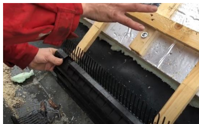
Figuur 5: Het plaatsen van isolatiemateriaal op het dak waarbij de dakconstructie niet wordt aangepast.
