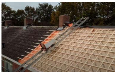
Figuur 6: een nieuw dak wat wordt gelegd op een oud dak.
