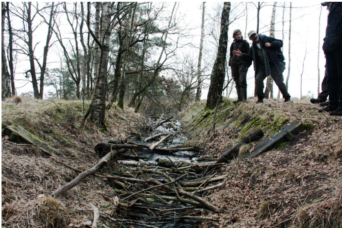
Figuur 19: Afwateringssloot noordzijde Flaes, voorzien van een lange betonnen dam.
