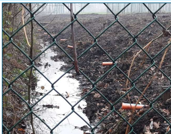
Figuur 3-9 Druppelende drainagebuizen vanuit het sportveld
