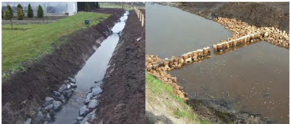
Figuur 1 en 2, Bypass om de Tullekensmolen in de Oude Beek nabij Beekbergen (links) en voorbeeld van een drempel met een palenrij (rechts). Bron foto's: B. Tolkamp Ecogroen
