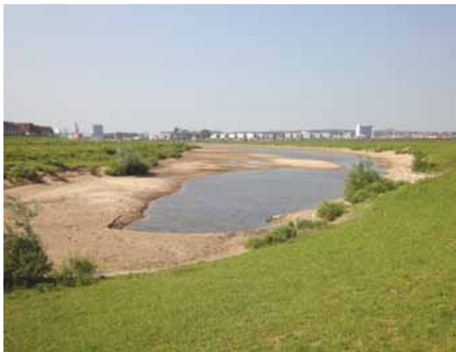
Figuur 55. Opslibbings- en aanzandingsstructuren op de bodem van de geul in de Bakenhof bij Arnhem tijdens laagwater. Inzet: de stroomsnelheden in de Bakenhofgeul liggen bij een gemiddelde afvoer op ca. 0,1 m/s; dit is relatief traag stromend (foto Bart Peters; kaartje Rijkswaterstaat).
