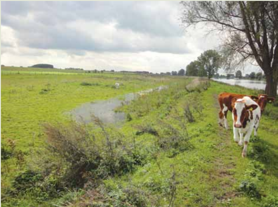
Figuur 31. Een recent aangelegde systeemvreemde oevergeul, zoals hier achter een hoge oeverdam bij Paalderen langs de Maas, herstelt niet de kenmerkende processen van vrije oevererosie, zanddynamiek en oeverwalvorming, maar staat ze juist in de weg (foto Bart Peters).
