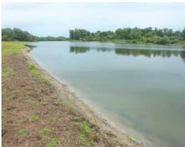
Figuur 54. Deze hoogwatergeul in de Duursche Waarden is in 2007 met relatief steile oevers in kleiige bodems aangelegd. Hierdoor zijn de ontwikkelingskansen niet optimaal. In de Fortmonderwaarden liggen aansluitend op deze geul uitstekende kansen voor een goed functionerende rivierkwelgeul (zie figuur 32), mits hierbij goed de onderliggende zanden worden opgezocht (foto Bart Peters).
