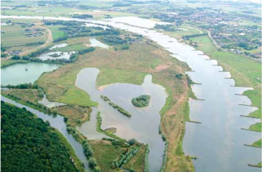
Figuur 40. De Blauwe Kamer tijdens de extreem lage afvoeren zomer 2003. Zichtbaar is dat de gegraven plas en hoogwatergeul desondanks vol water staan en geen uitdrogende oeverzone kennen. Ook in de oevers van de rivier zijn geen zandige rivierstrandjes zichtbaar (foto Bert Boekhoven).
