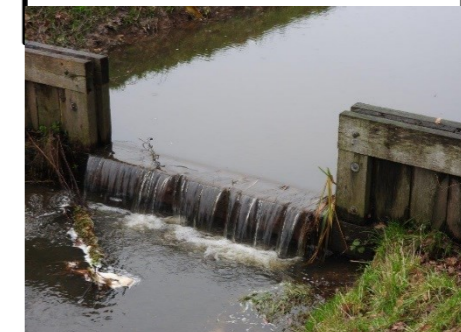
Stuw bovenstrooms 1540 benedenstrooms 1510
