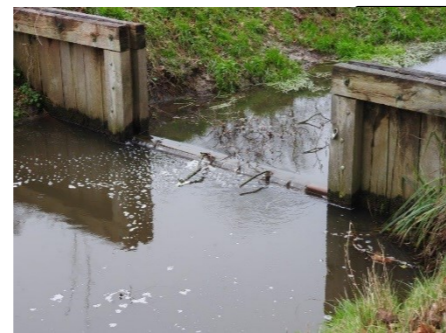
stuw met peilschaal bovenstrooms 1550 benedenstrooms 1540
