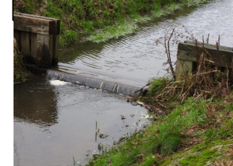
stuw bovenstrooms 1510 benedenstrooms 1500
